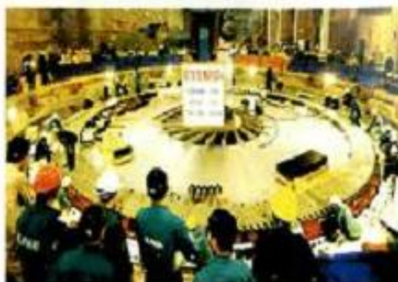
Lắp đặt thành công tổ máy số 4 (Ảnh: www.baovietdung.com.vn)
