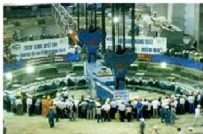
Mừng tổ máy số 1 Nhà máy Thủy điện Sơn La hòa lưới điện quốc gia (Ảnh: www.tienphong.com.vn)
