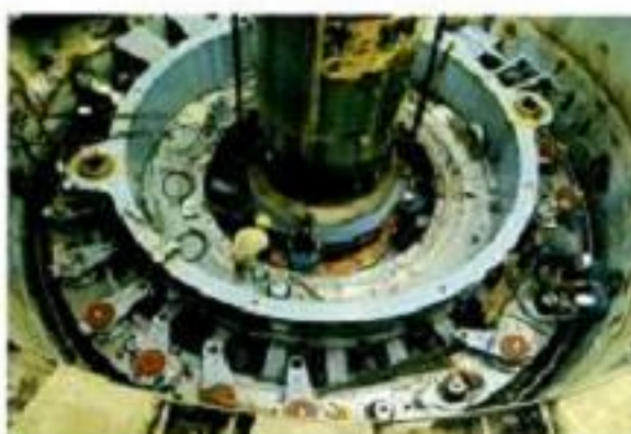
Lắp đặt sator tổ máy số 5 (Ảnh: www.evu.com.vn)
